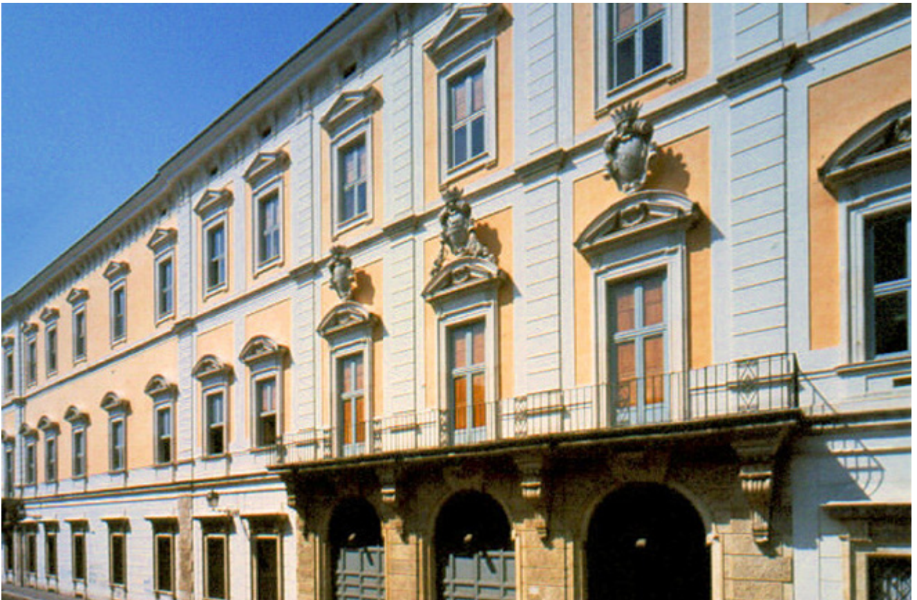
FOTO 1. Palazzo Corsini. Esterno
