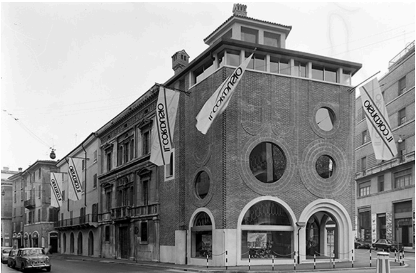
Foto 2. Cordusio a Brescia, parzialmente demolito negli anni '30 e ricostruito negli anni '70 come grande magazzino, da
