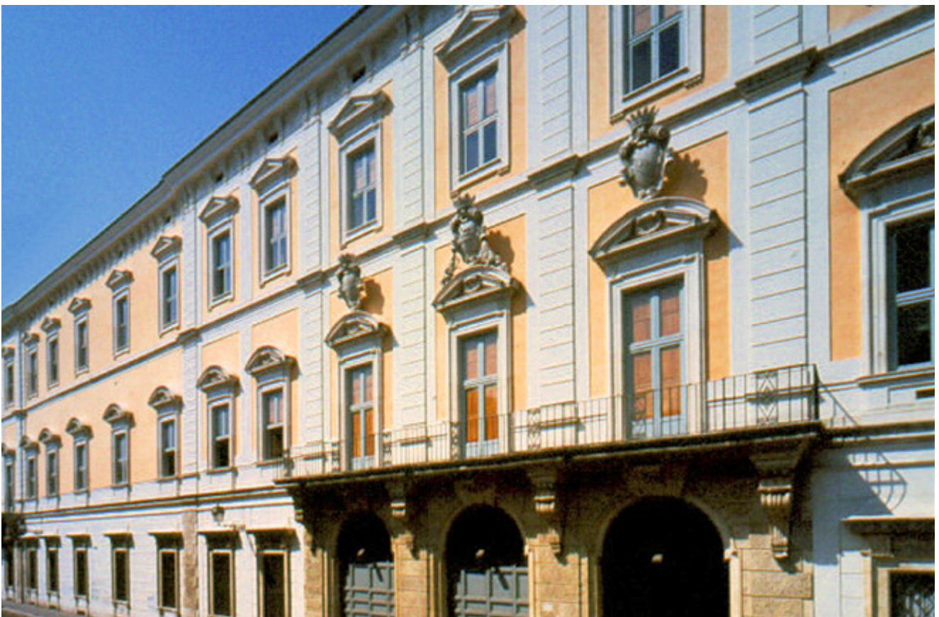
FOTO 1. Palazzo Corsini. Esterno
